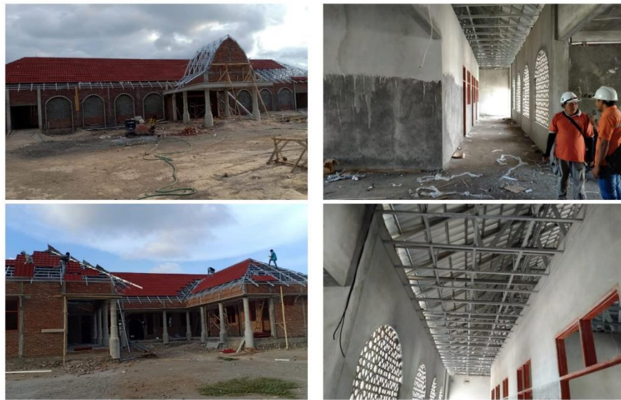
Gambar 9. Pekerjaan Atap dan Plafond
