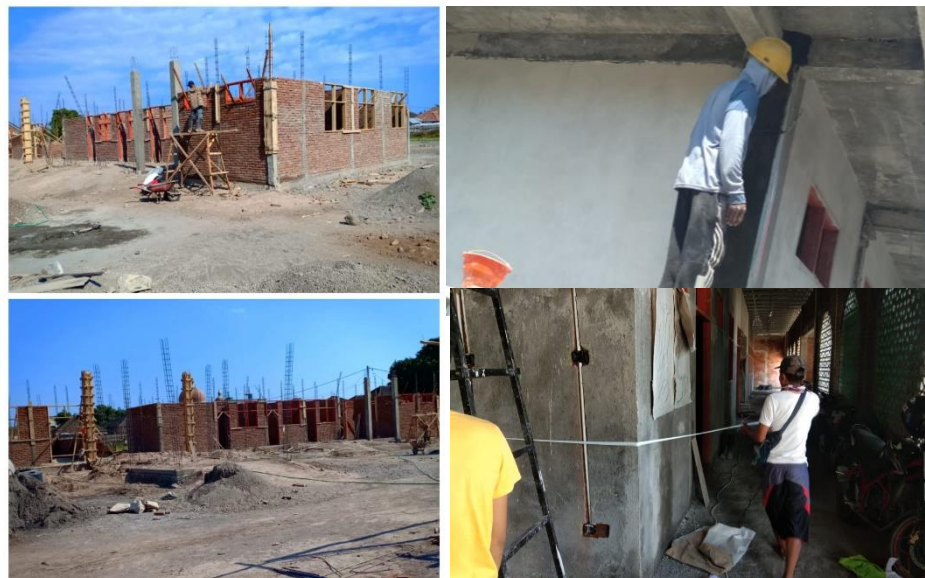
Gambar 8. Pekerjaan pemasangan batu bata dan Plesteran
