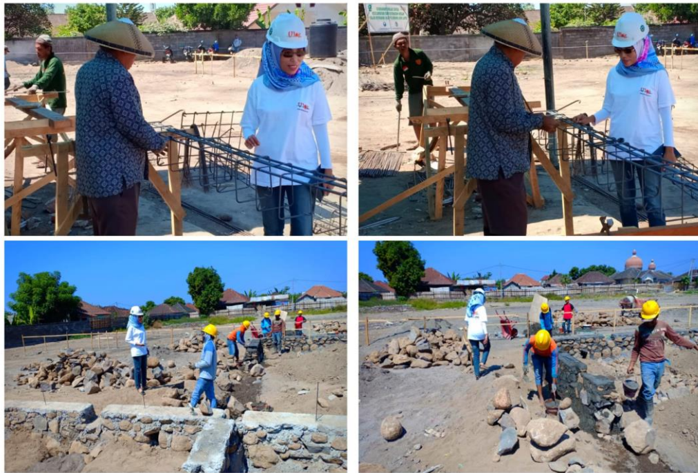
Gambar 7. Pekerjaan pembesian dan pondasi batu kali
