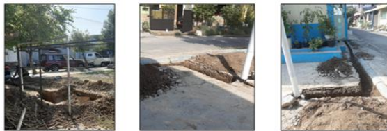
Gambar 7. Pemasangan inlet penghubung sumur
