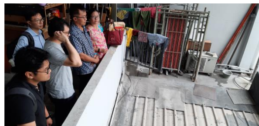
Gambar 7. Kondisi lantai 2 untuk melihat kondisi dan ketinggian ruang yang akan dirancang
