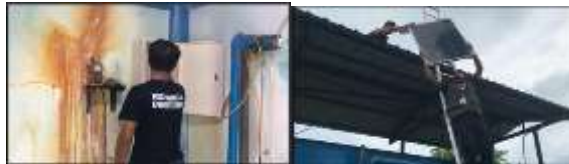
Gambar 8. Pemasangan Solar Panel
