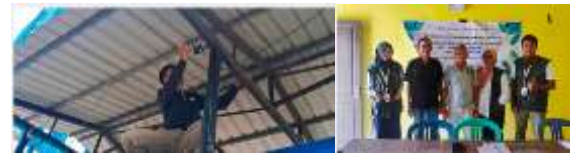
Gambar 9. Pemasangan CCTV dan Sosialisasi Website
