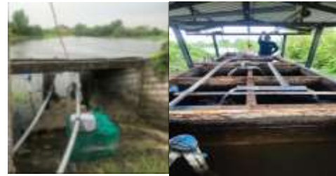
Gambar 5. Pompa dan Filter Air
