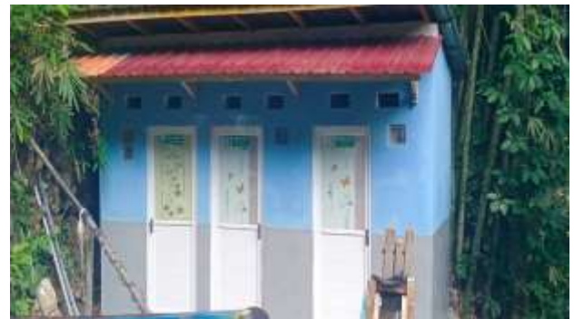
Gambar 3. (Toilet dan kamar ganti setelah renovasi di kolam pemandian Aikdewa)
