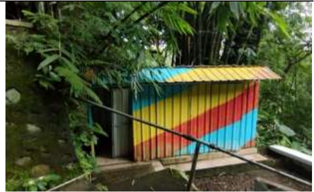
Gambar 2. (Toilet dan kamar ganti sebelum renovasi di kolam pemandian Aikdewa)
