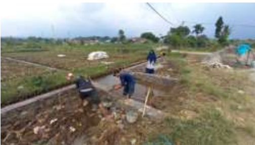
Gambar 7. Tahap pelaksanaan Konstruksi Sumber Tim Abdimas
