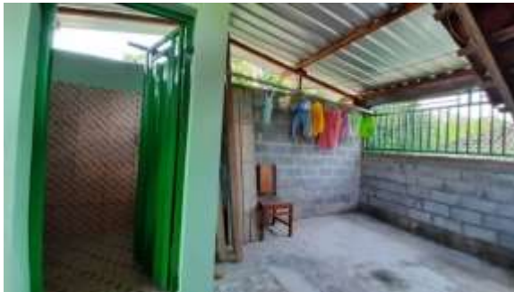
Sumber: Dokumentasi tim (2023)
