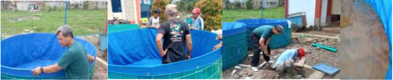
Gambar 4. Perancangan dan pembangunan kolam lele dan salurannya di Desa Citeureup.
