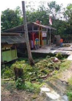
Gambar 2. Proses perbaikan atap ruang belajar yang rusak
