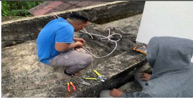
Gambar 2. Proses wiring dan grounding PV
