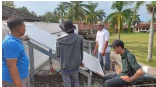
Gambar 1. Proses pembuatan penyangga dan pemasangan PV
