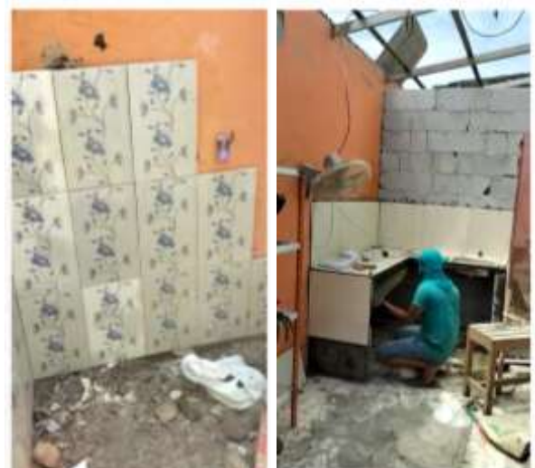
Proses perbaikan berlangsung ± 1 minggu yang dibantu oleh total 4 pekerja
