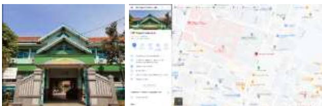
Gambar 1. Foto Gedung SMPN 2 Surakarta dan Peta Lokasi
