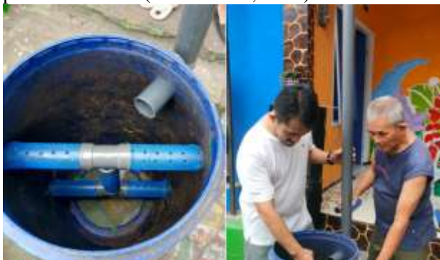
Gambar 4. Tampak penyambungan pipa komposter aerob.
