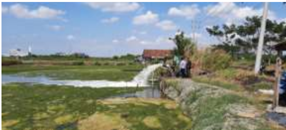
Gambar 1. Distribusi air laut menggunakan pompa
