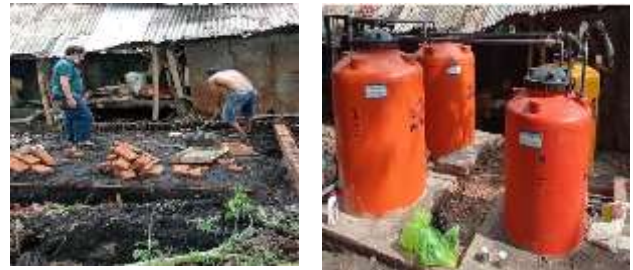
Gambar 12. Pembuatan Fasilitas Pembuatan Biogas Dari Limbah Cair
