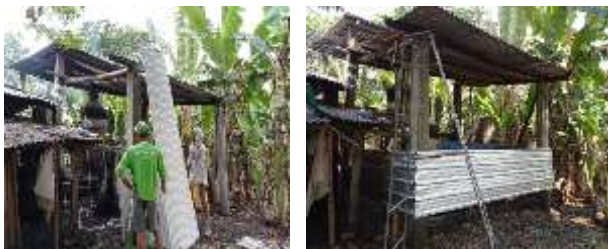
Gambar 11. Pembuatan fasilitas Pengoahan ampas tahu menjadi pelet pakan ikan
