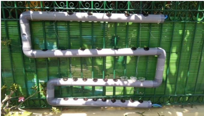
Gambar 2. Hasil Akhir Instalasi Hidroponik Sumber: Dokumentasi Kegiatan, 2021
