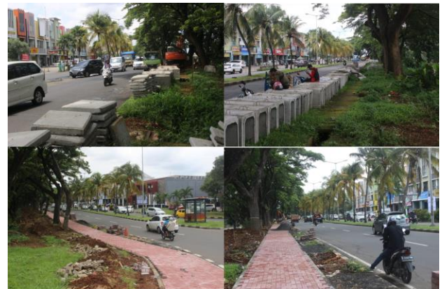
Gambar 6. Pekerjaan Pembangunan Jalur Pejalan Kaki
