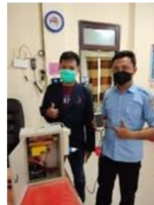
Gambar 14. Implementasi pembangkit listrik tanpa bbm di Kelurahan manggar
