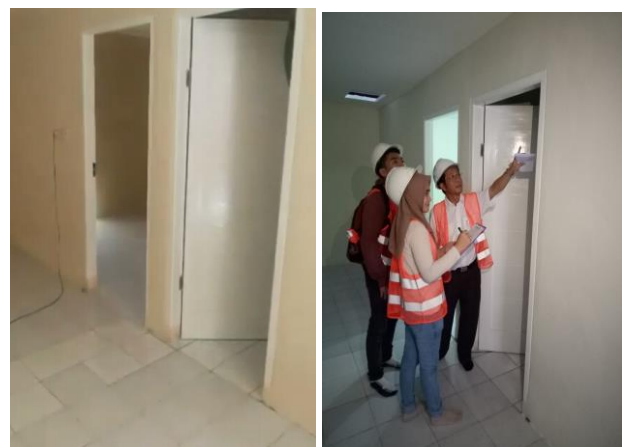
Gambar 10. Interior rumah pak Taufick (kiri) dan pengecekan kualitas pekerjaan oleh Tim PkM (kanan)
