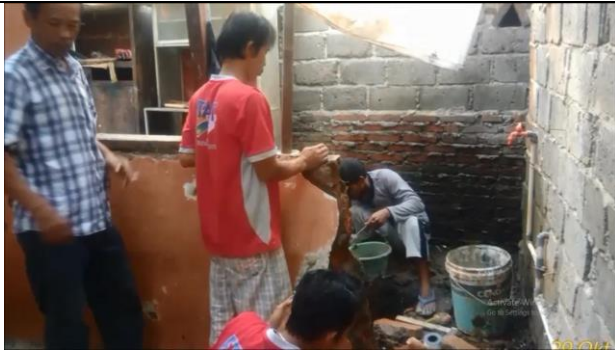
Gambar 5. Pekerjaan plambing dan sanitasi
