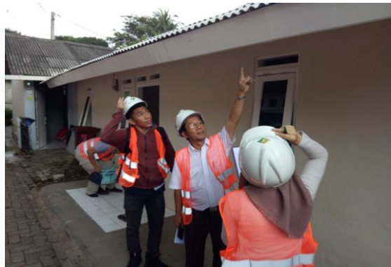
Gambar 12. Pengecekan hasil pekerjaan oleh Tim PkM (tampak samping)
