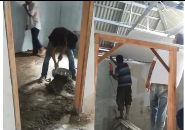
Gambar 8. Pekerjaan pemasangan kusen
