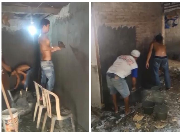
Gambar 7. Pekerjaan plester dinding
