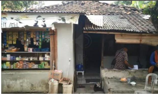
Gambar 1. Kondisi eksterior rumah bapak Taufick
