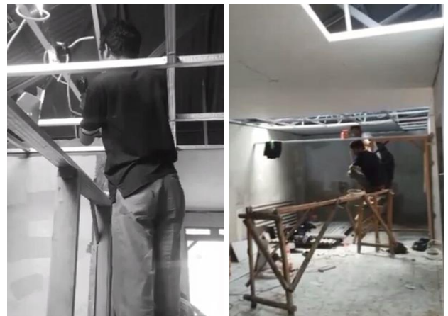
Gambar 9. Pekerjaan pemasangan rangka plafon (kiri) dan pemasangan plafon (kanan)
