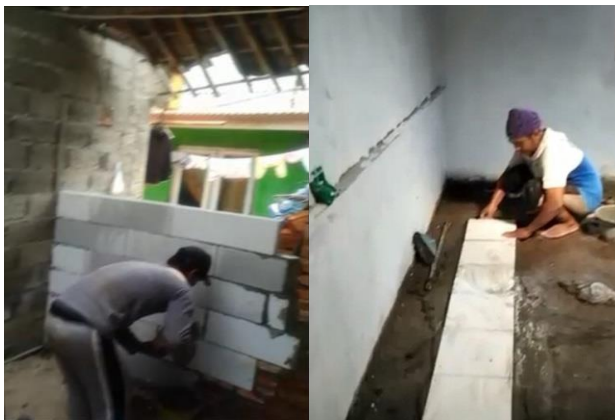
Gambar 6. Pekerjaan pemasangan dinding bata ringan (kiri) dan pemasangan keramik lantai kamar (kanan)
