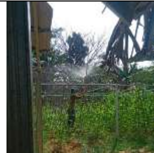
Gambar 4. Pemasangan Instalasi Sprinkler .
